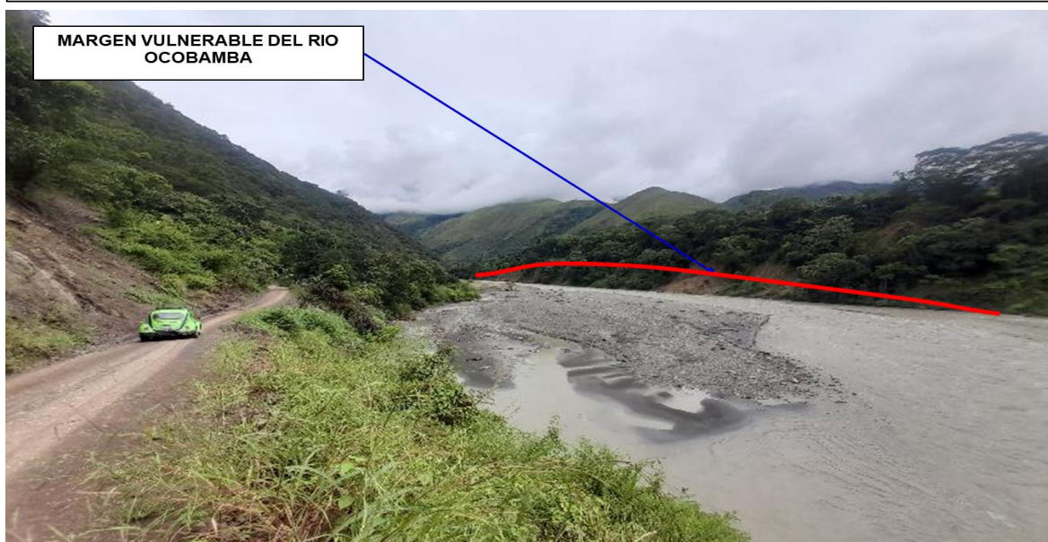
FIGURA N°02: EN LA EPOCA DE MAXIMAS AVENIDAS, EL RÍO OCOBAMBA, PRODUCE EL SOCAVAMIENTO EN ESTE TRAMO SE PROPONE EL ENROCADO
